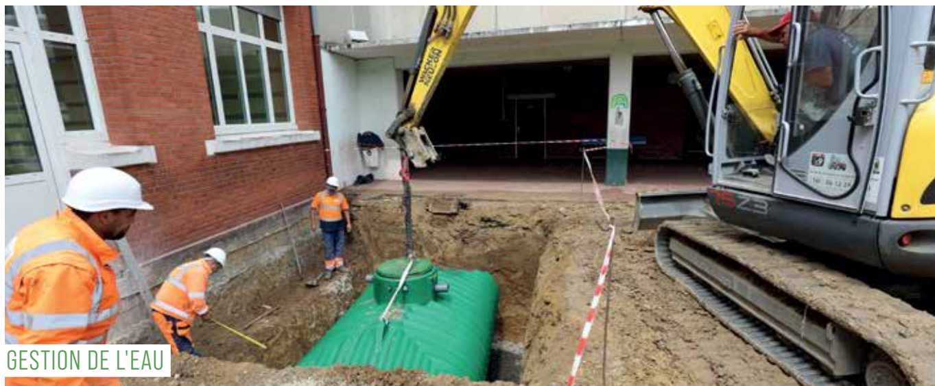
Cuves de récupération d'eau de pluie installées dans la cour de l'école Jules-Ferry.
