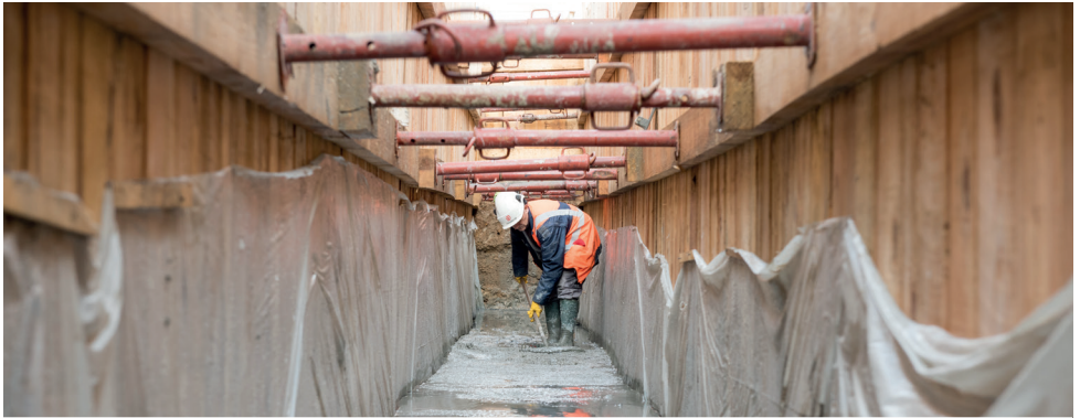
Gare Maison Blanche – Paris XIII e , dévoiement des réseaux concessionnaires.
